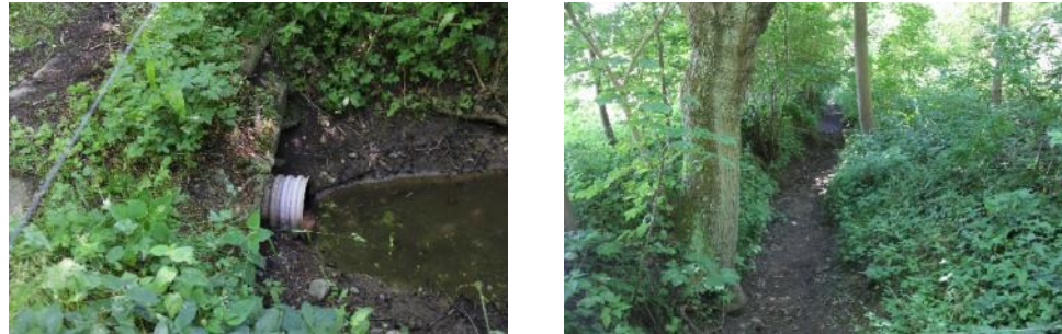
Figur 7: Ærtesnareløbet. Tv. udløb fra rørbro st. 797 m, med vandsamling. Th. vandløbet set nedstrøms rørbro st. 797 m, der var udtørret. Foto d. 22. juni 2018.
